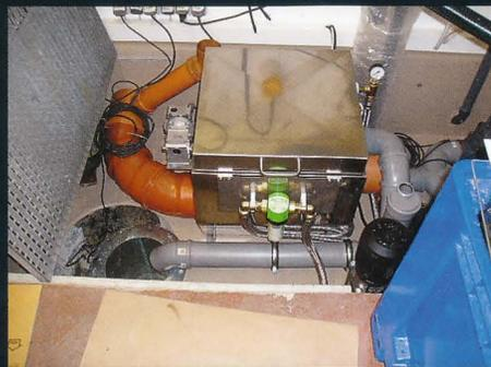
32 Einbau und Anschluss des Trommelfilters.
