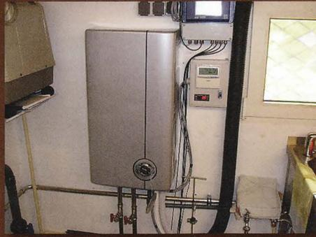
46 Das dazugehörige Hydraulikteil mit Steuerung im Filterhaus.
