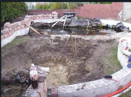
**04** Nun folgen das Betonieren des Ringankers und der erste Aushub.
