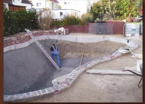
09 Das Modellieren der Betonwände wird in mühsamer Arbeit von Hand erledigt.
