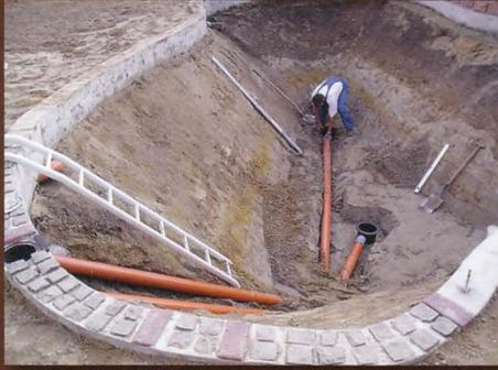
07 Nach den Erdarbeiten werden die Rohr Strecken der zwei Bodenabläufe und des Skimmers verbaut.
