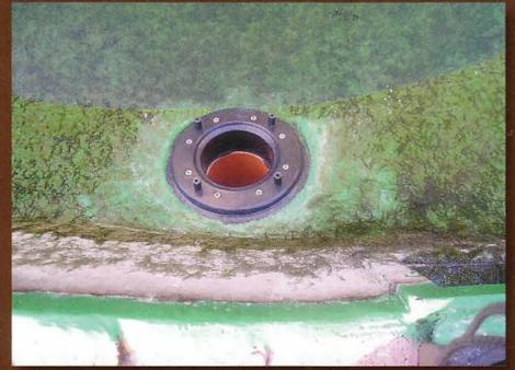
27 Nach erfolgter Kernbohrung. Einbau eines Seitenflansches mit Deckel.
