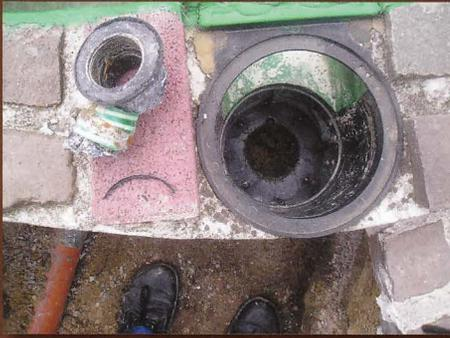
25 Umbau des Wandskimmers. Entfernen des Schlauchanschlusses.
