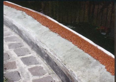
42 Fertig betoniert. Obenauf kam eine Mixtur aus eingefärbten Steinchen und farblosem Topcoat.
