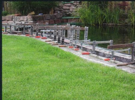
41 Schalung zur Erhöhung des vorderen Teichrandes mit Beton.
