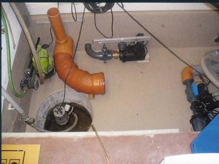
31 Anschluss der Biokammer an den Trommelfilter und Ansaugleitung zur Pumpe des O<sub>2</sub>-Reaktors.
