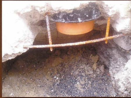
26 Einpassen und Einkleben eines modifizierten KG-Deckels in DN 110.
