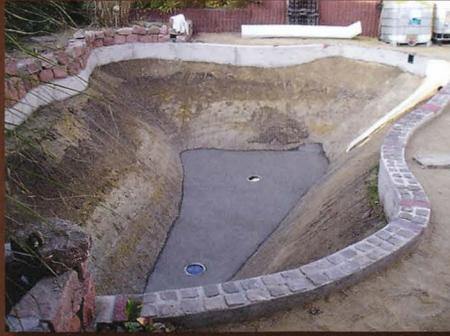
08 Der Teichboden wird aus Beton gegossen.
