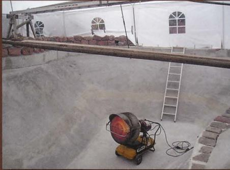
10 Die Betonarbeiten sind abgeschlossen. Die Baustelle ist überdacht und wird für das Laminieren vorbereitet.
