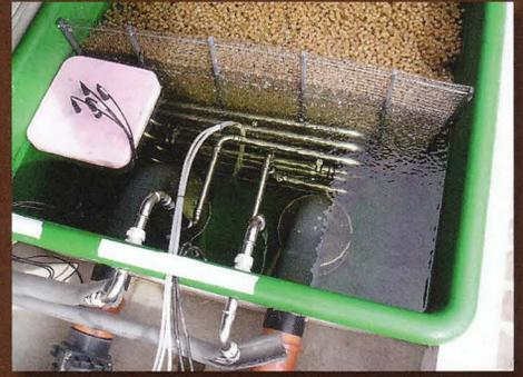
47 Der VA-Wärmetauscher in der Biokammer.
