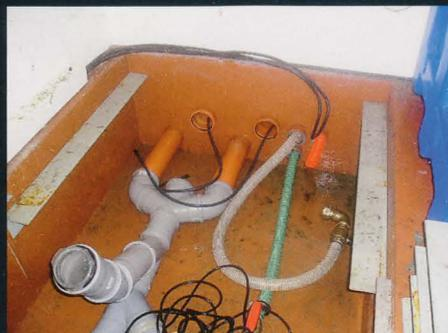
24 Teilweiser Ausbau der alten Filtertechnik. Der Rest war während der Maßnahme weiter in Betrieb.
